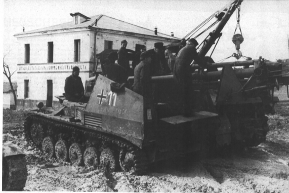
Nach mehr als 10.000 Schuß werden die Rohre der "Wespen" ausgetauscht. Von einem Zgkw 8 t werden die Rohre mit Wiege und Luftvorholer, d. h. als Oberlafette, von dem Waffenmeister-Trupp durch Kran übernommen und genau eingeschoben, wie hier 1944 in Italien. (BA)
