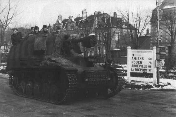
Diese "Wespe" befindet sich 1944 auf einem Verlegungsmarsch durch Beauvais (Frankreich) in Richtung Paris. Die Bedienung besteht aus Geschützführer, Fahrer und drei Kanonieren. Der Kampfraum hat in der Regel keinen Witterschutz nach oben, für die Männer im Winter sehr unangenehm. (BA)
